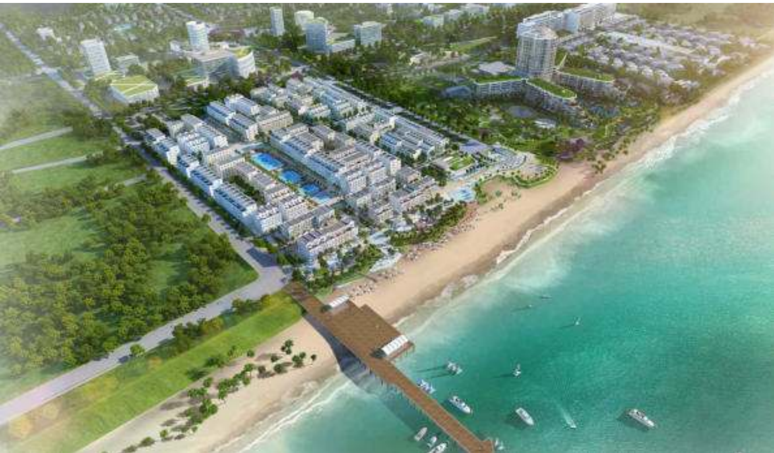
Waterfront - Phú Quốc, Kiên Giang - Cung cấp và lắp đặt cửa thép & cửa cuốn chống cháy - Quy mô: 32.000 m 2
